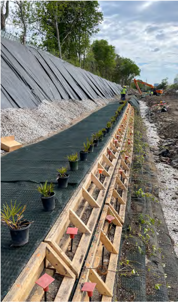
En la foto de la izquierda: La vegetación desmontada del lugar se reutilizó en muchas aplicaciones, incluso para construir estructuras dentro del cauce, como se muestra aquí. En la foto de arriba: El talud estabilizado reforzado con vegetación (VRSS), un elemento clave del diseño del proyecto, se construyó en parte utilizando materiales orgánicos reutilizados procedentes de la limpieza del terreno.
